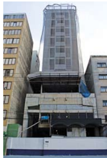
O Hospital do Coração em obras
